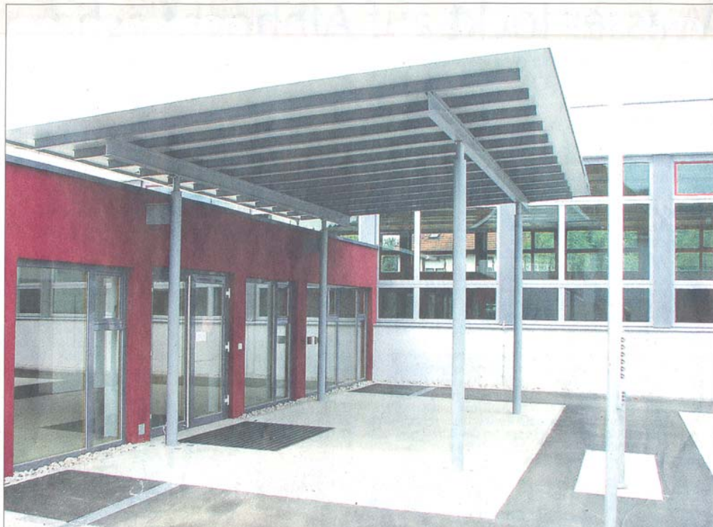
Der neue Sanitärtrakt und das erweiterte Hallenfoyer der Turn- und Festhalle Schlatt werden am Sonntag eingeweiht.
